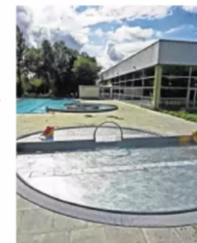
Becken und Anlage sind gereinigt worden. PT
